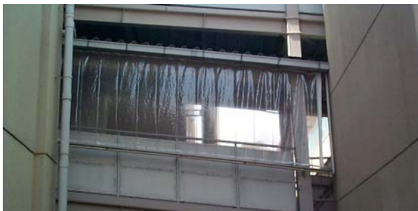
渡り廊下にビニールカーテンを取り付けました。 透明タイプを使用すれば、採光性は失われません。
