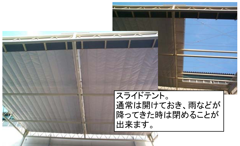
外階段へテント屋根の取り付け。
