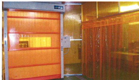
シートシャッターとビニールカーテン
