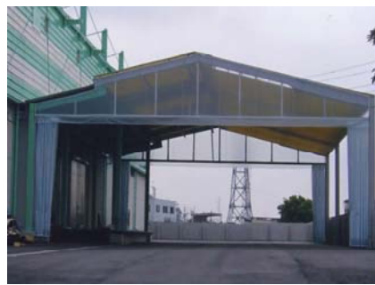
テント屋根 (トラック)
