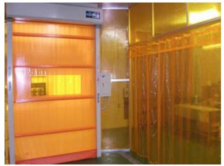
出入口シートシャッター+ビニールカーテンで間仕切
