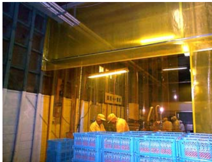
出入口ビニールカーテン+固定壁で間仕切
