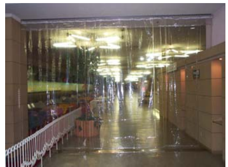
出入口ビニールカーテンで間仕切
