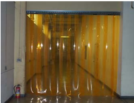
出入口のれん式ビニールカーテンで間仕切
