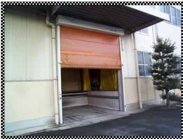
糸入防虫防災シート使用
